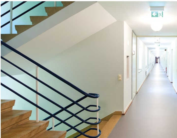
Der Gästetrakt im „Haus auf der Alb“ wurde komplett saniert und modernisiert.
