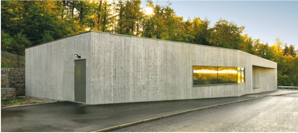
Neues Tunnelbetriebsgebäude am Herrschaftsbucktunnel in Rheinfelden.
