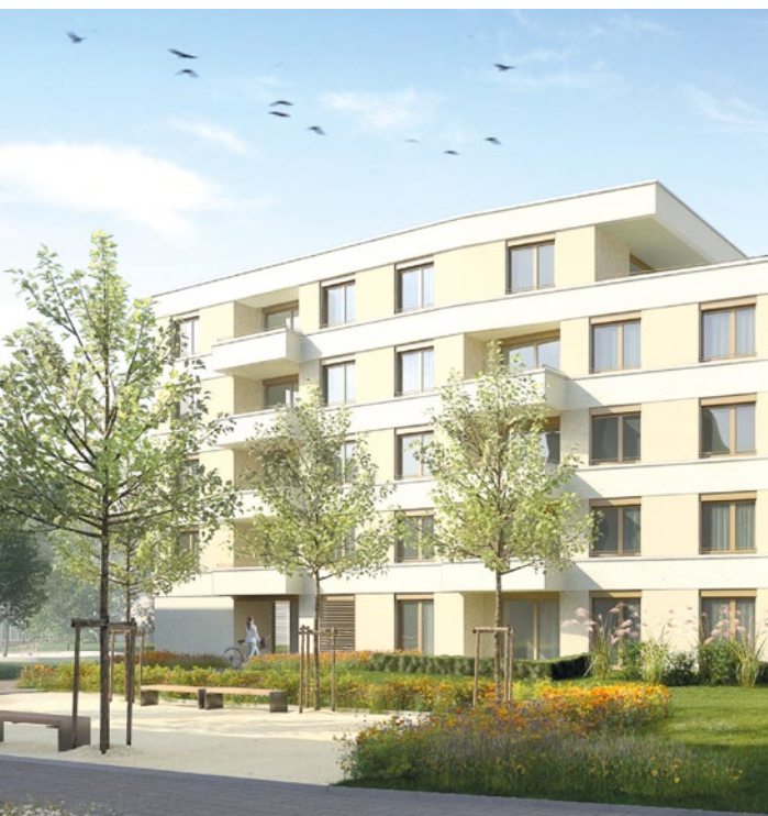
Müllheim, Quartier Q5 – Nachverdichtung mit Neubauten und Sanierungen im Bestand.
