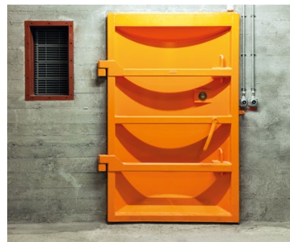
Schutztür zu den Lagerstollen.
