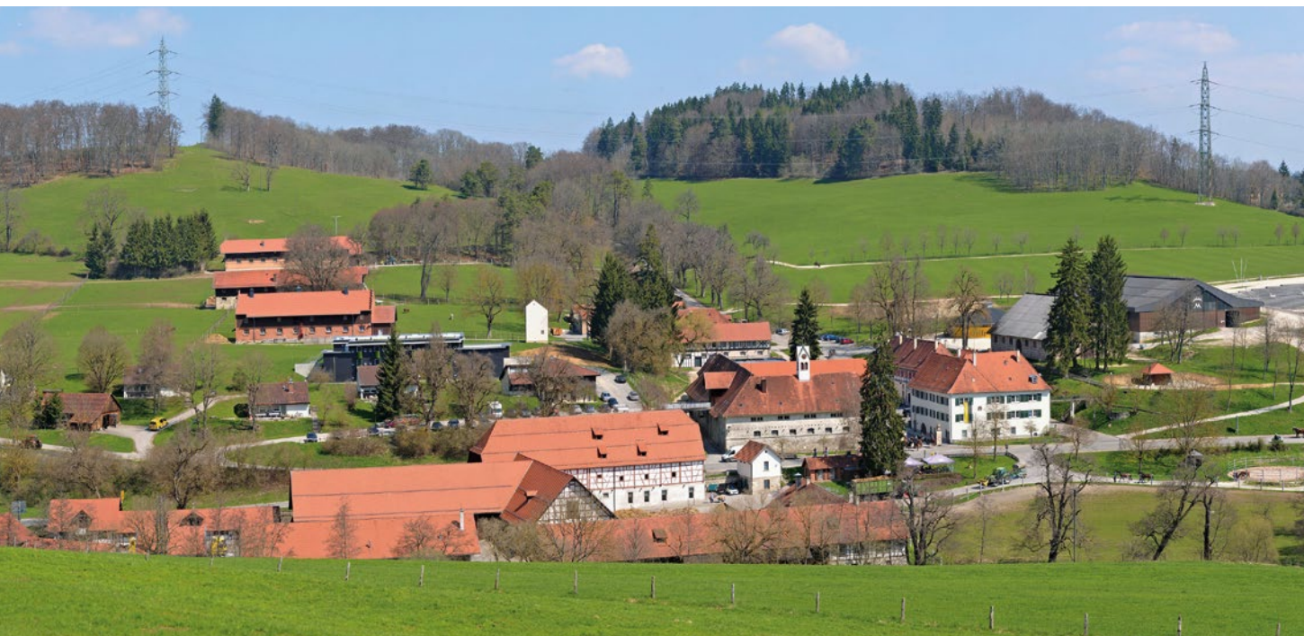
Am Haupt- und Landgestüt Marbach wurden im Zeitraum von 2009 bis 2023 diverse Sanierungsmaßnahmen und Neubauten realisiert.
