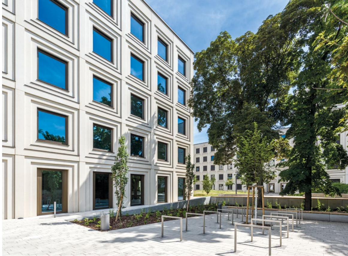
Beim neuen Gebäude des Leibniz-Instituts für Sozialwissenschaften GESIS im Zentrum von Mannheim konnten zwei Bäume erhalten werden. Der Neubau hat einen Anschluss an das Fernwärmenetz und auf dem extensiv begrünten Flachdach ist eine PV-Anlage installiert.
