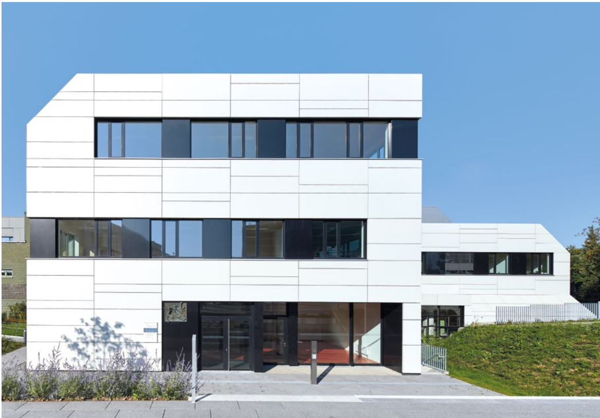
Die neue Apotheke des Universitätsklinikums Tübingen ist in einem aufgestockten, erweiterten Bestandsgebäude untergebracht.
